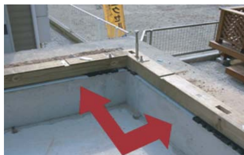
基礎パッキン工法
